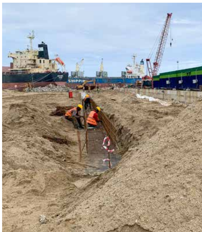
BULK PORT TERMINAL UNDER CONSTRUCTION IN CÔTE D'IVOIRE
